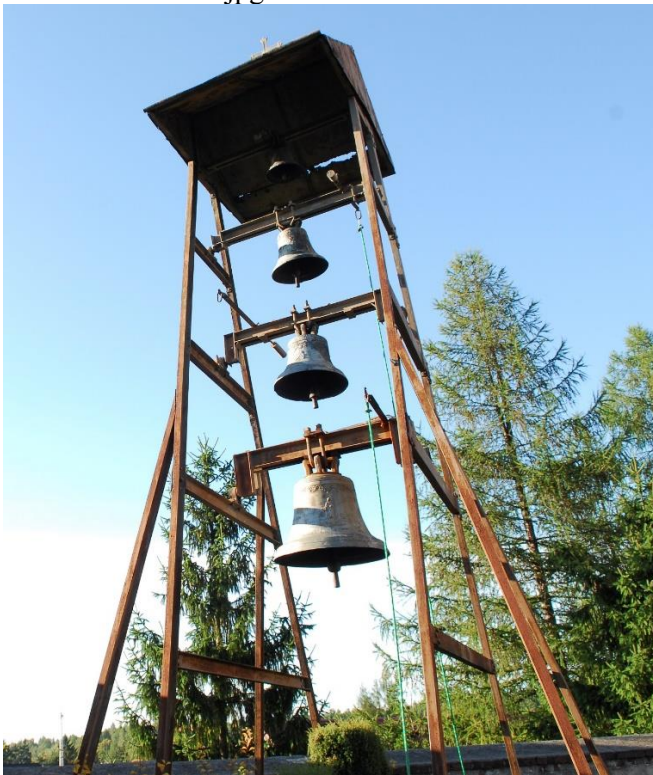
1Dzwonnica 2014 rok z 4 dzwonami
